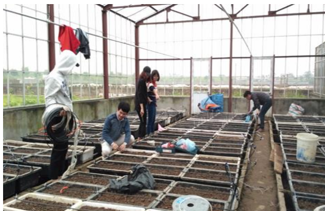
Hình 2. Lắp đặt hệ thống tưới nhỏ giọt
